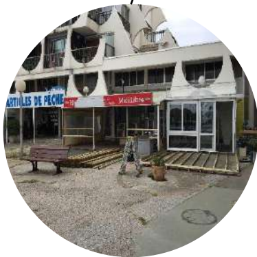
Terrasse ouverte avec plancher
